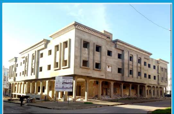
Travaux de construction de l'établissement de protection sociale (Orphelinat) à Kénitra (B3) Phase de finitions.
